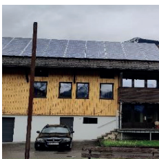
Haus Trausenegger Sanierung alter Wohntrakt und Ausbau Tenne
