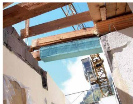
Abriss bis auf die Grundmauern: Das Dach wurde um 90 Grad gedreht.
