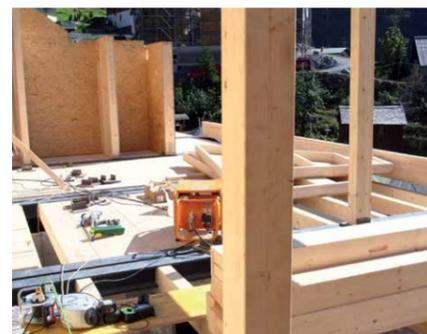
Das oberste Stockwerk besteht aus einer Holzkonstruktion, aufliegend auf einer Stahlkonstruktion.
