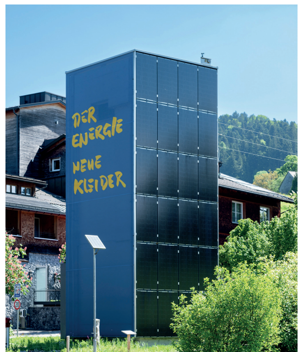
PV-Strom ist einer der wichtigsten erneuerbaren Energieträger in Langenegg, auch bei der Trafostation in Langenegg. (© Mario Nussbaumer)
