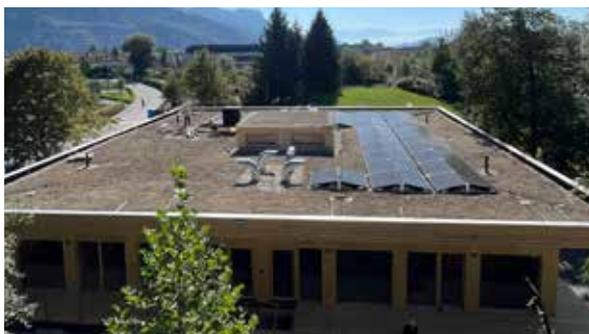
Eine Photovoltaik-Anlage mit 24 kWp Leistung liefert Sonnenstrom.
