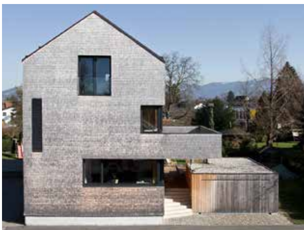
» Westfassade mit vorgefertigten Holz-Stroh-Elementen und Holzschindeln.
