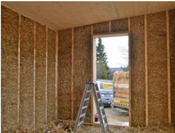
» Holz-Stroh-Ständerkonstruktion vor der Anbringung der Holz-Innenverschalung.
