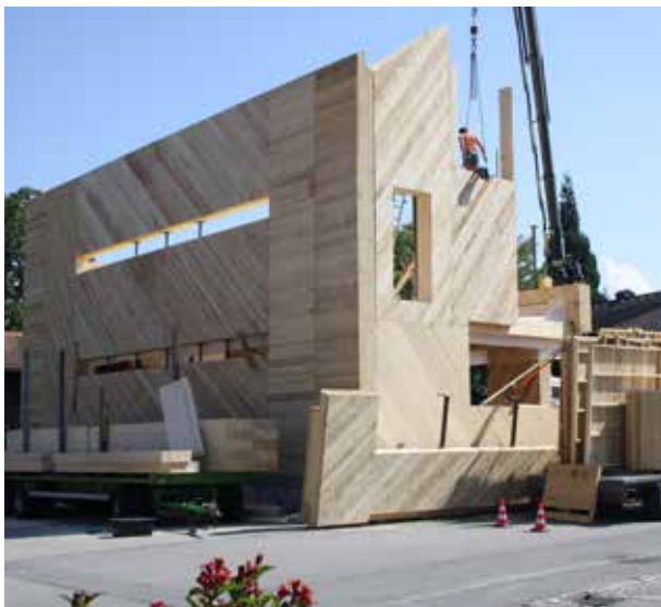
» Die vorgefertigte Holz-Stroh-Elementbauweise sorgt für kurze Bauzeiten.
