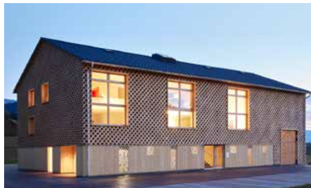
» Die Denkwerkstätte wurde mit Stroh und Schilf gedämmt.
