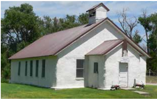
» Die Pilgrim Holiness Church in Nebraska ist mit ca. 100 Jahren eines der ältesten, noch erhaltenen Strohballengebäude.
