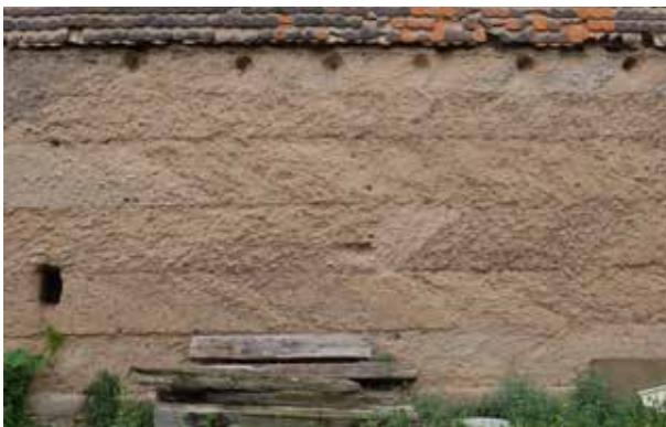
» Eine Scheune im Lehmwellerbau, die ca. 1900 errichtet wurde.
