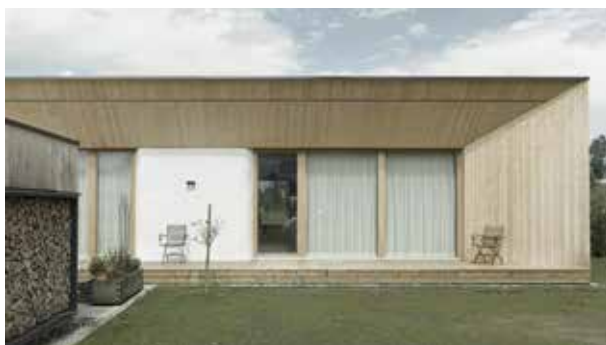
» 120 cm dicke lastentragende Strohballen-Wände mit Terrasse und Vordach.
