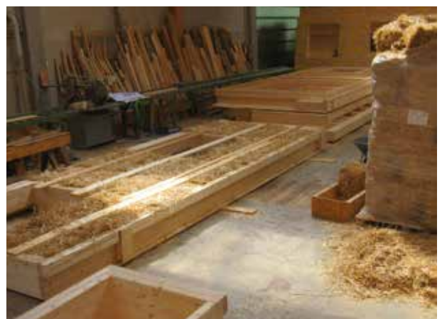
» Befüllung der vorgefertigten Holzelemente mit Stroh im Zimmereibetrieb.
