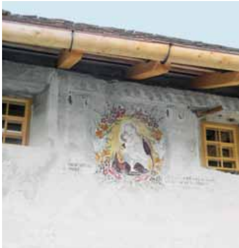
Konstruktiver Schlagregenschutz durch Dachüberstand
