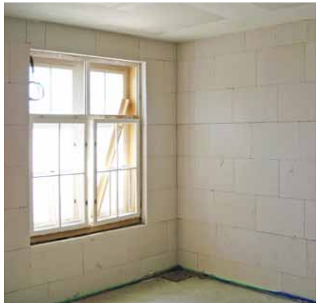
Mineraldämmplatten noch ohne Deckputz
