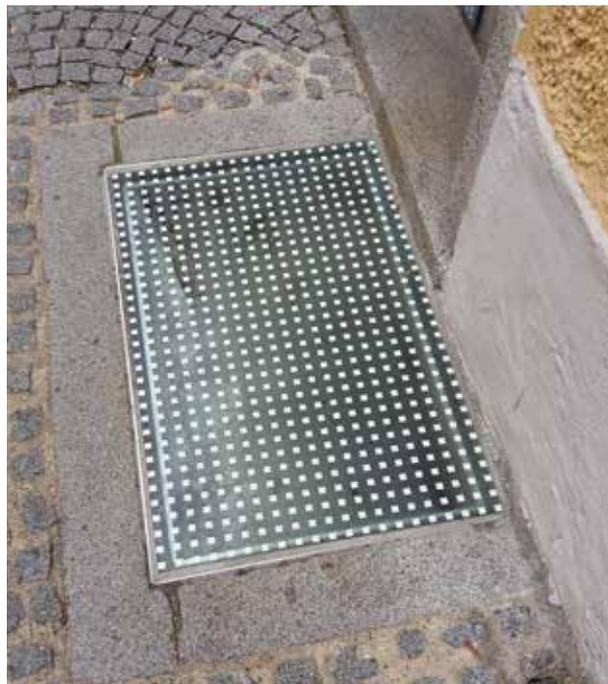
Abb. Abgedichteter Lichtschacht
