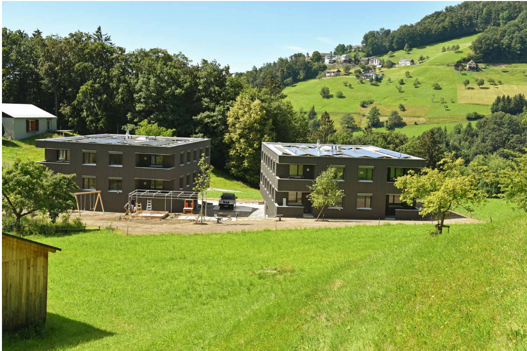
Abbildung 1: Mehrfamilienhäuser in Dafins. Haus A (links), Haus B (rechts); PV-Anlage, E+1, je 6 Wohnungen; Foto: Energieinstitut Vorarlberg
