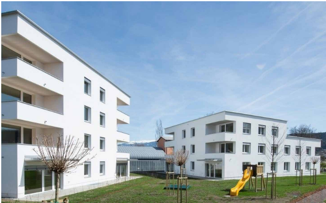
Abbildung 1: Ansicht Nordblock (links) und Südblock (rechts); Foto: Neue heimat Tirol/Vandory
