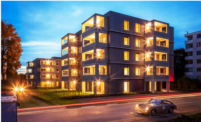
Abbildung 1: Mehrfamilienhäuser in Wolfurt. Vorne Haus (A) Holzbau, PV-Anlage, E+4, 18 Wohnungen. Hinten Haus (B) Massivbau, Solarthermie, E+3, 15 Wohnungen; Foto: Weissengruber
