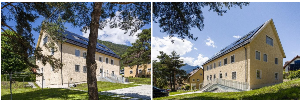
Abbildung 12: kleines Gebäude nach Sanierung; Fotos: Walser-image
