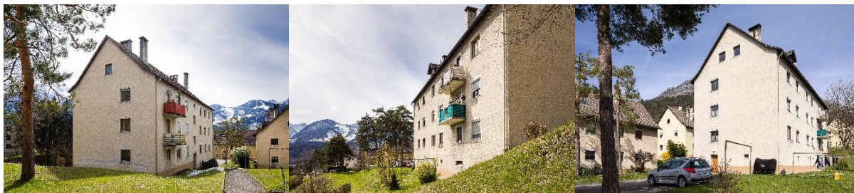
Abbildung 10: großes Gebäude vor Sanierung; Fotos: Walser-image
