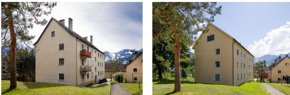
Abbildung 4: Gebäude vor und nach der Sanierung (Foto links: Energieinstitut Vorarlberg, Foto rechts: Dietmar Walser)
