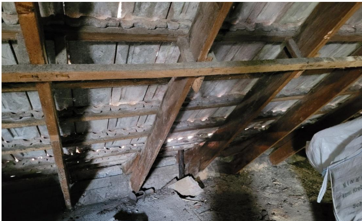
Abbildung 3: Dachstuhl mit Holzsparren. Dachlattung und Biberschwanzziegeln (Foto: Energieinstitut Vorarlberg)
