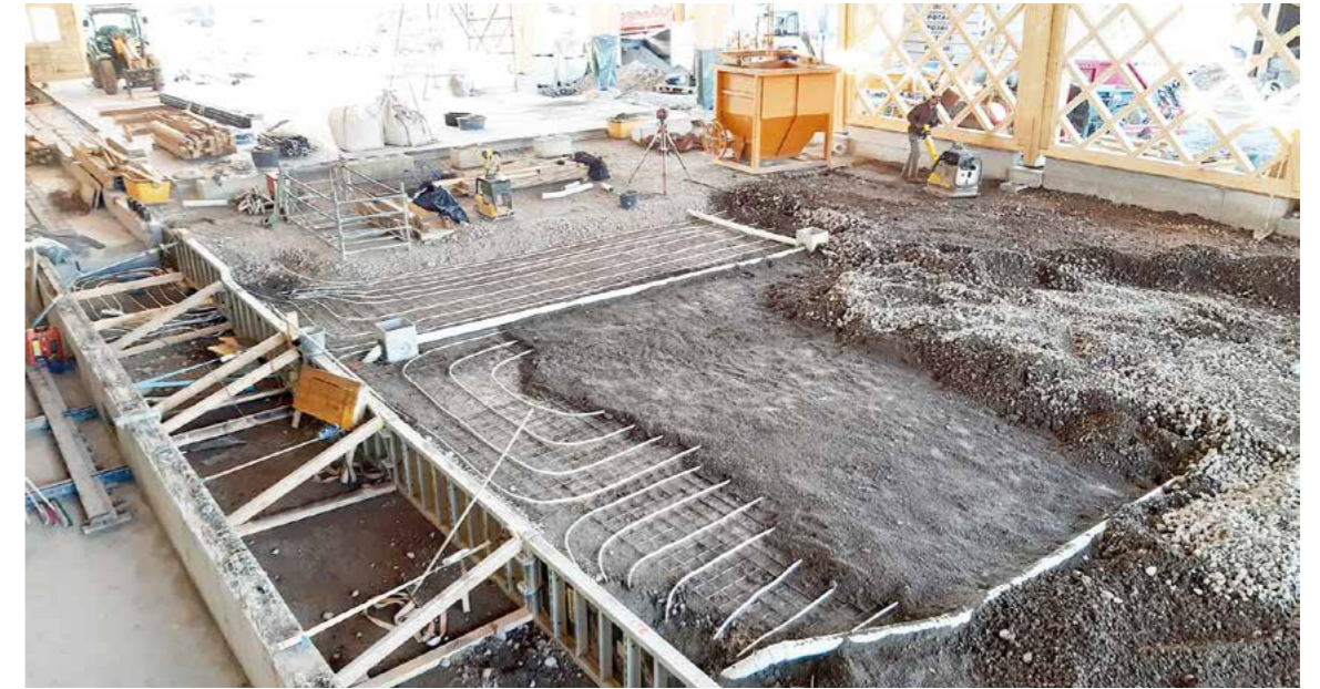
Bauprozess in der bereits aufgerichteten Halle
