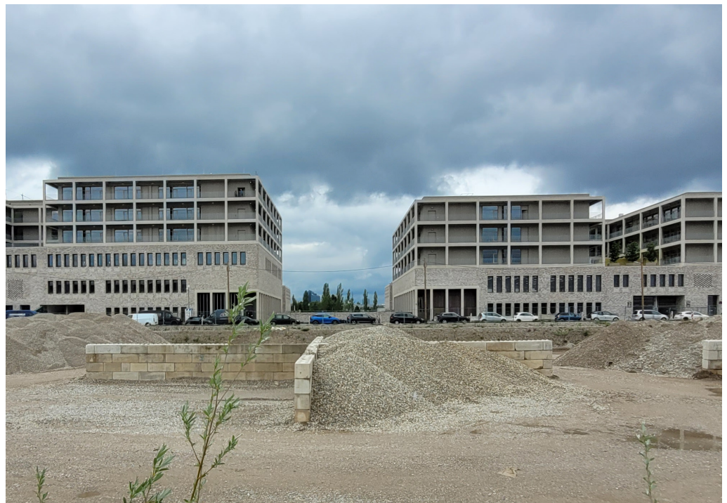
Abbildung 9: Abbruch der Bayernkaserne und Neubauten im Stadtquartier Neufreimann München (©EIV)
