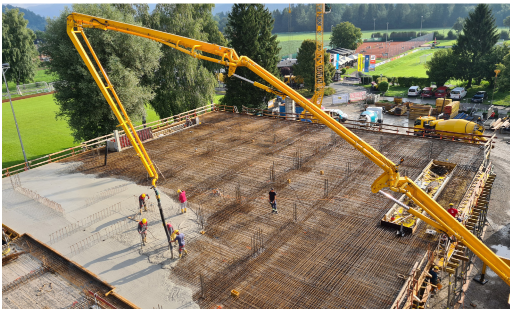
Abbildung 9: Volksschule Anif - Auftragen des Recyclingbetons (© Salzburg Wohnbau)
