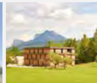
Plusenergie-Bürogebäude und Kulturkraftwerk oh456, Thalgau, Salzburg
