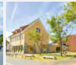
Sanierung Gemeindeamt Zwischenwasser, Muntlix, Vorarlberg
