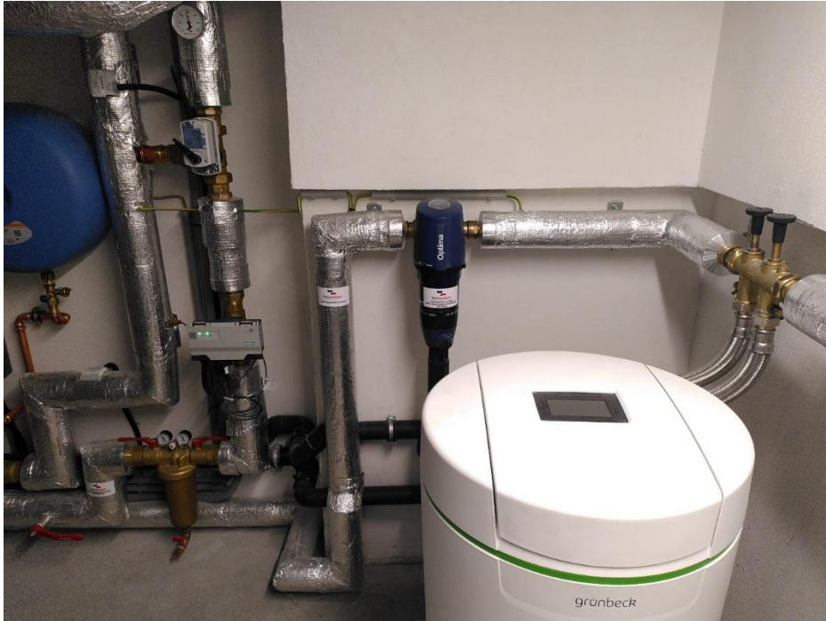
Abbildung 76: Verrohrung im Heizungskeller mit Fehlstellen der Leitungsdämmung, Haus 12a; Foto: Planungsteam E-Plus
