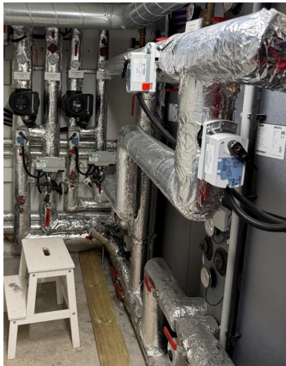
Abbildung 113: Leitungsdämmung Heizkeller kleines Gebäude nach Nachbesserungsarbeiten; Fotos: Energieinstitut Vorarlberg
