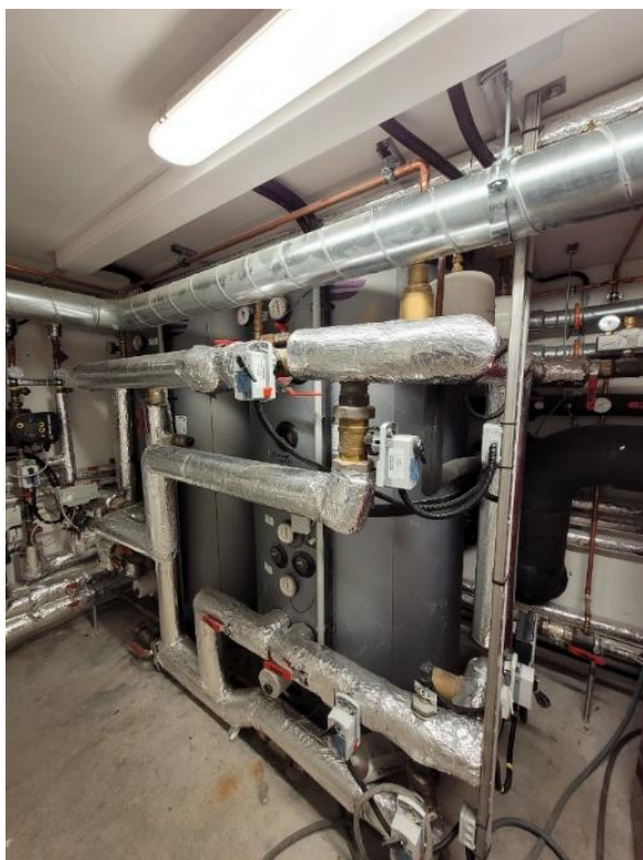
Abbildung 112: Leitungsdämmung Heizkeller kleines Gebäude mit Fehlstellen vor Nachbesserungsarbeiten; Fotos: Energieinstitut Vorarlberg
