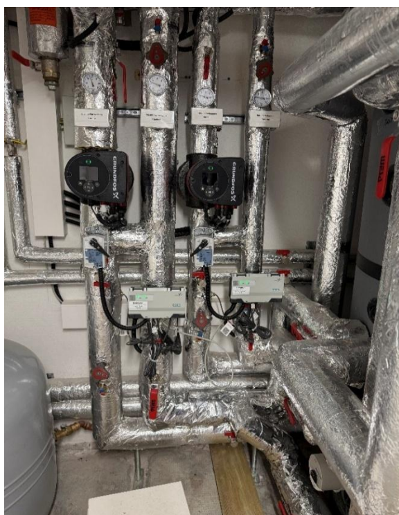
Abbildung 113: Leitungsdämmung Heizkeller kleines Gebäude nach Nachbesserungsarbeiten; Fotos: Energieinstitut Vorarlberg
