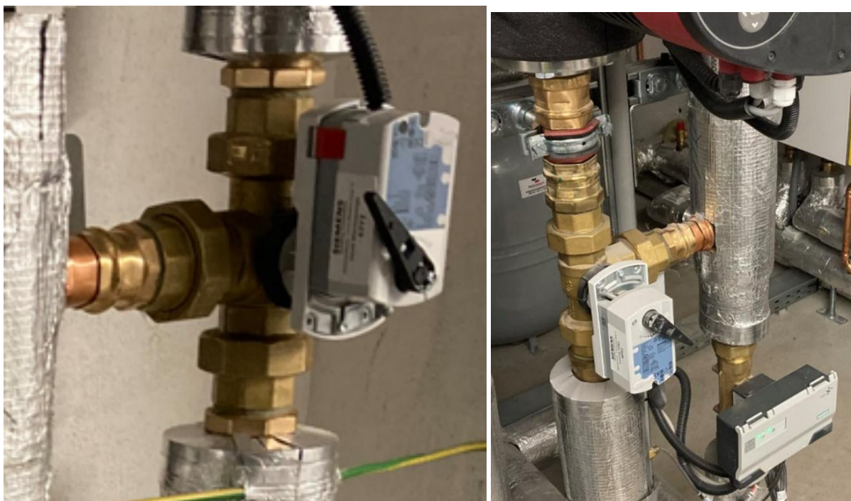
Abbildung 78: Fehlstellen in der Leitungsdämmung, Haus 12a; Fotos: Planungsteam E-Plus
