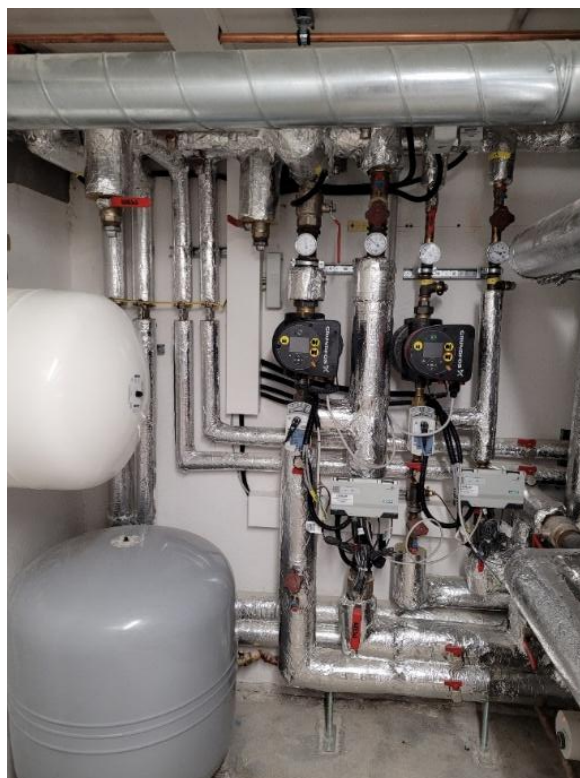
Abbildung 112: Leitungsdämmung Heizkeller kleines Gebäude mit Fehlstellen vor Nachbesserungsarbeiten; Fotos: Energieinstitut Vorarlberg
