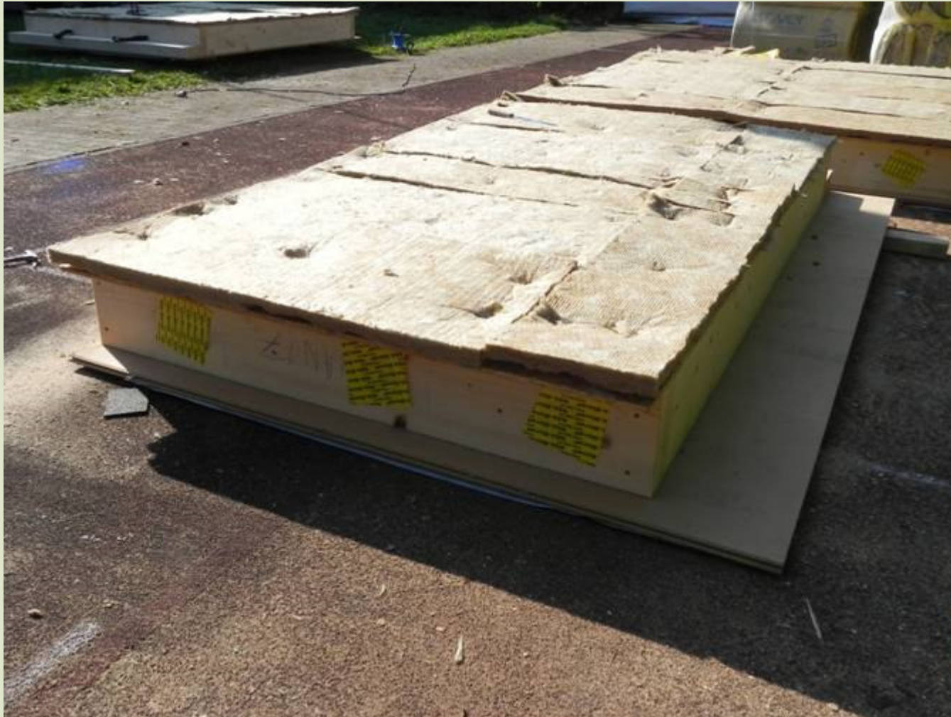
Im Werk vorgefertigtes Fassadenelement (klein) auf Lagerplatz
