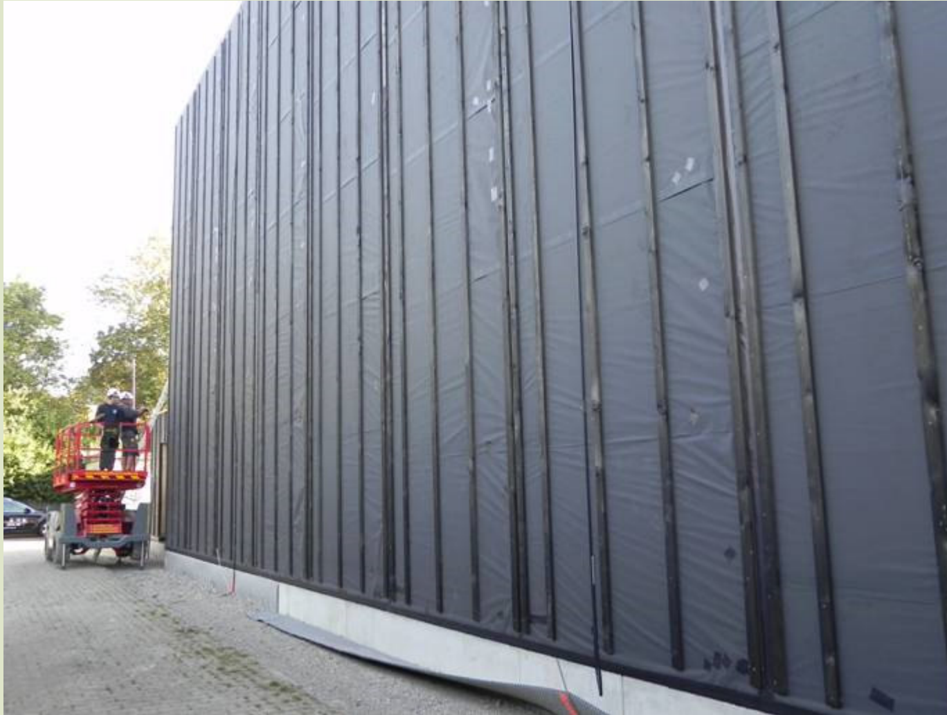
komplett vorgebaute Energiefassade auf der Westseite
