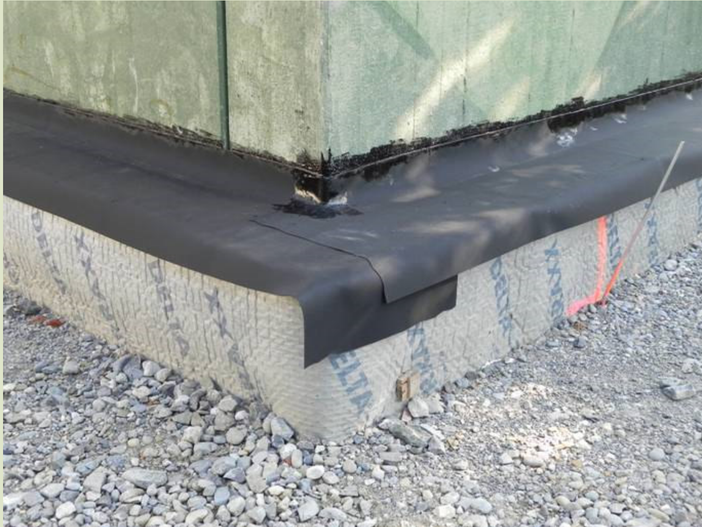
vorgesetztes Streifenelement mit Feuchtigkeitsschutz
