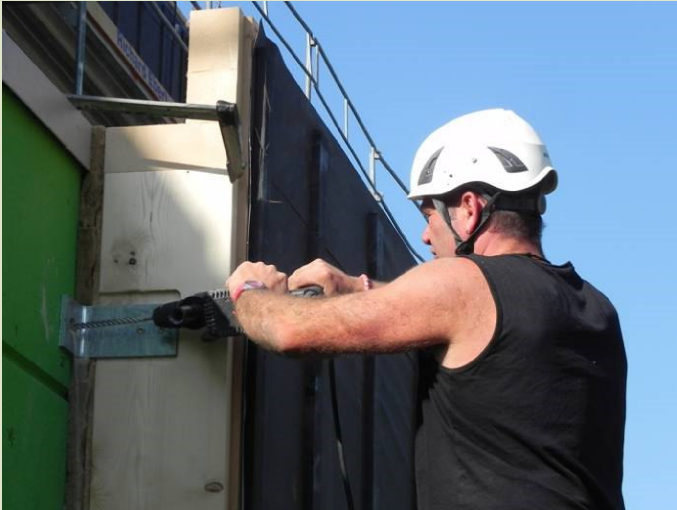
Vorbereitung Fixierung mit Spreizdübel
