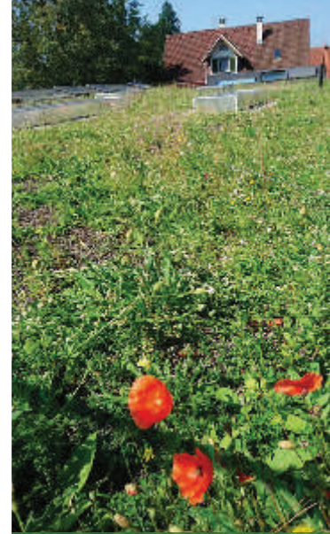
Naturnahe Dachbegrünung © Katrin Löning
