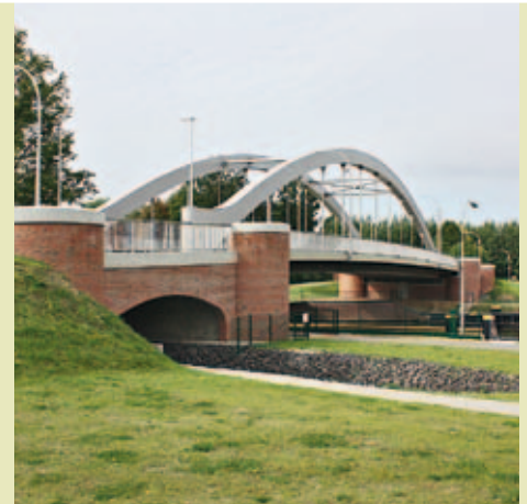
Abb. 7 Geothermisch beheizte Brücke in Berkenthin. Quelle: H.S.W. Ingenieurbüro Rostock
