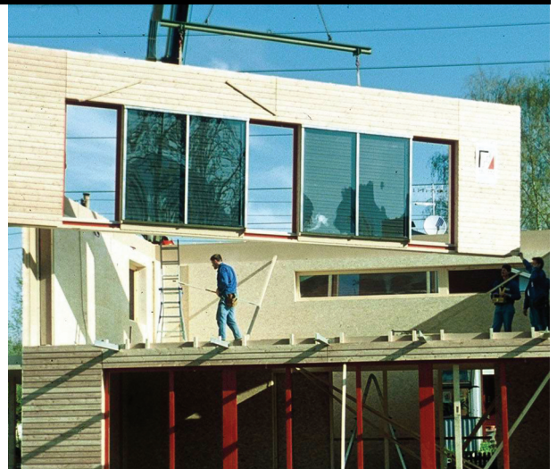
Montage von vorgefertigten Raumelementen
