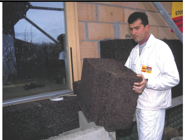
Dämmsystem als Korkfassade mit 35 cm Dämmdicke
