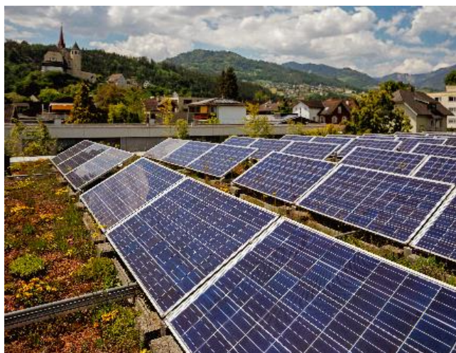
Abbildung 1: Gründach in Kombination mit einer PV-Anlage, Haus Klosterreben Rankweil (© Markus Gmeiner, 2021)
