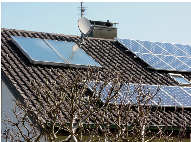
Kollektorflächen wirken optisch wie zufällig abgestellt.
