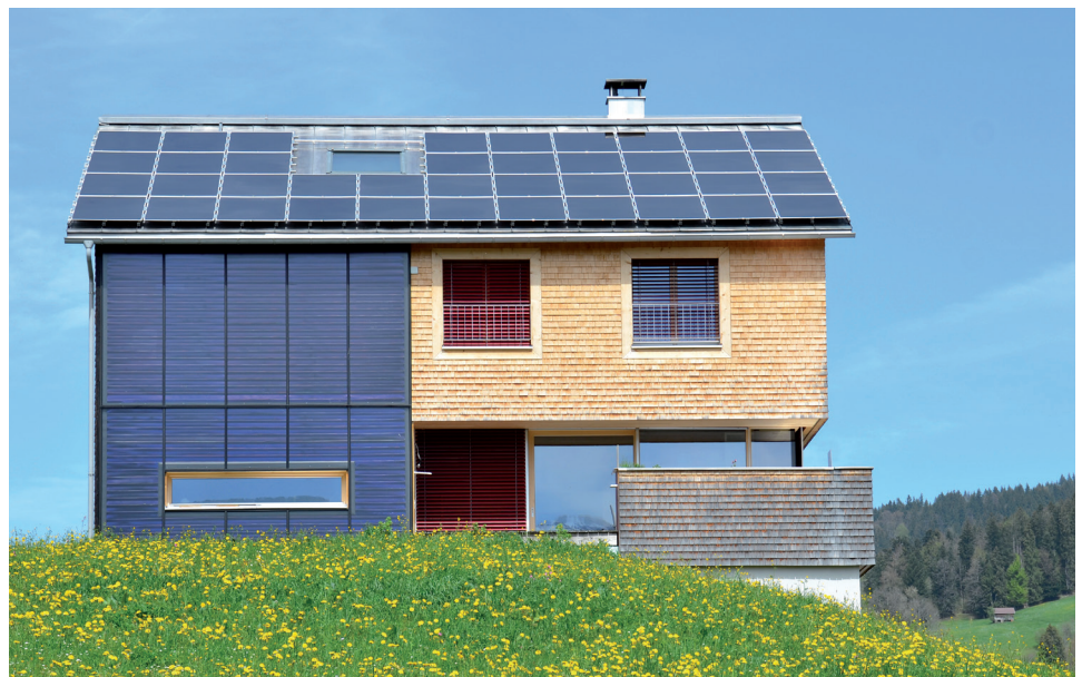
Vorbildlich in Dach und Fassade integrierte Photovoltaik- und Solaranlage.
