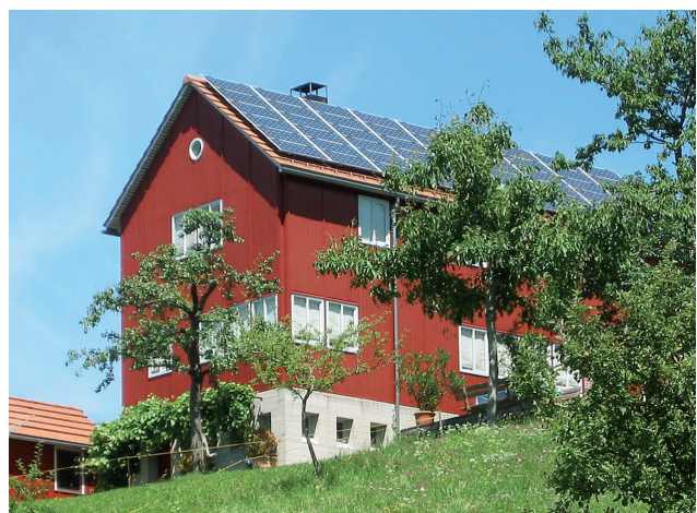
Zusammenhängende, rechteckige Fläche. Symmetrisch zur bestehenden Dachfläche.
