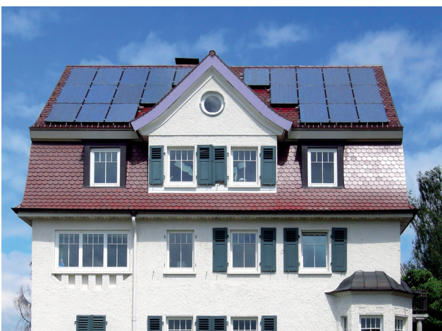
Die Kollektoren beeinträchtigen den Gesamteindruck.
