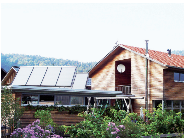
Die Orientierung der Kollektorfläche auf dem Pultdach gegen Süd bringt zwar rund 15% Mehrertrag, beeinträchtigt jedoch das gestalterische Erscheinungsbild.
