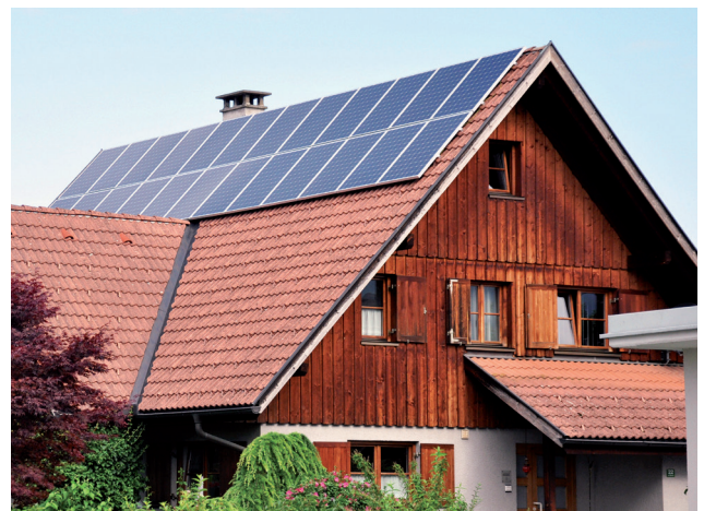
Sowohl bei der fassadenintegrierten als auch der dachintegrierten Anlage sind die Proportionen zum Gebäude harmonisch.
