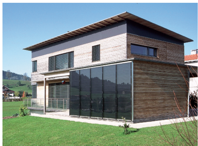
Gelungene Wandintegration im Nebengebäude.
