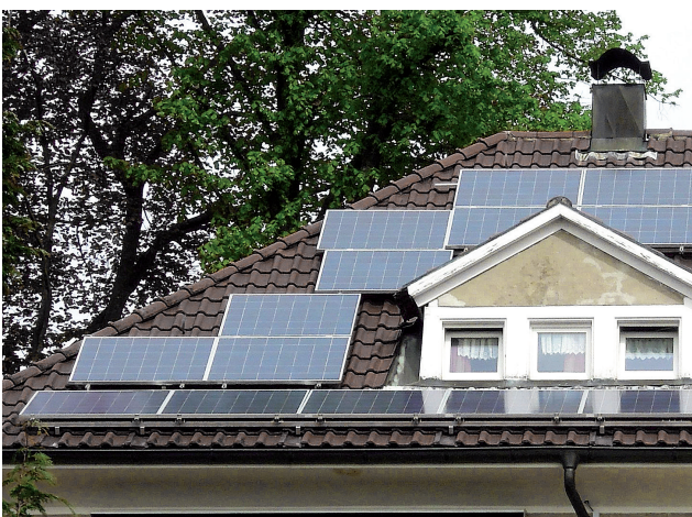
Getrepte Kollektoren beeinträchtigen die Dachform.
