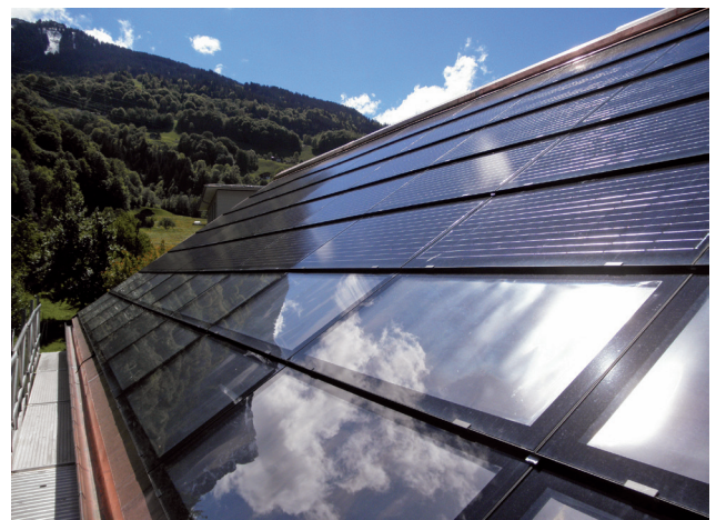
Thermische Kollektoren und Photovoltaik-Module in die Dachhaut integriert. Optisch ansprechend, dabei mit geringeren Wärmeverlusten.
